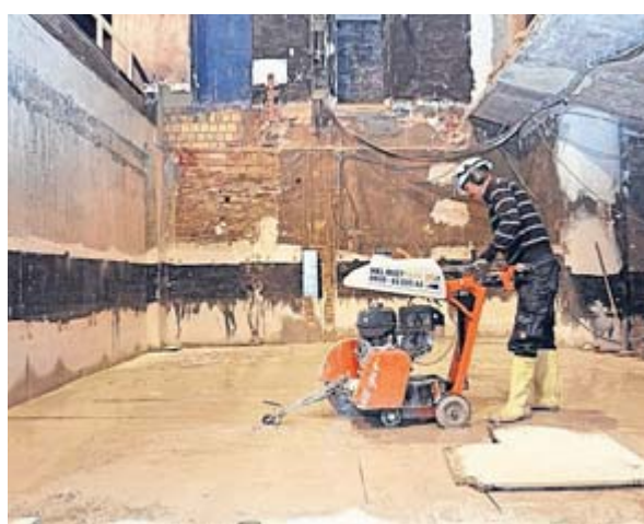
An vielen Stellen im Haus sind Bauarbeiter zugange, so wie an dieser Stelle im Orchestergraben.
